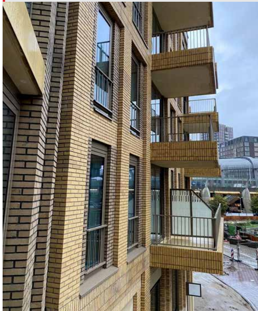
Gemêleerd metselwerk tegen de achtergrond van metrostation Noord.
