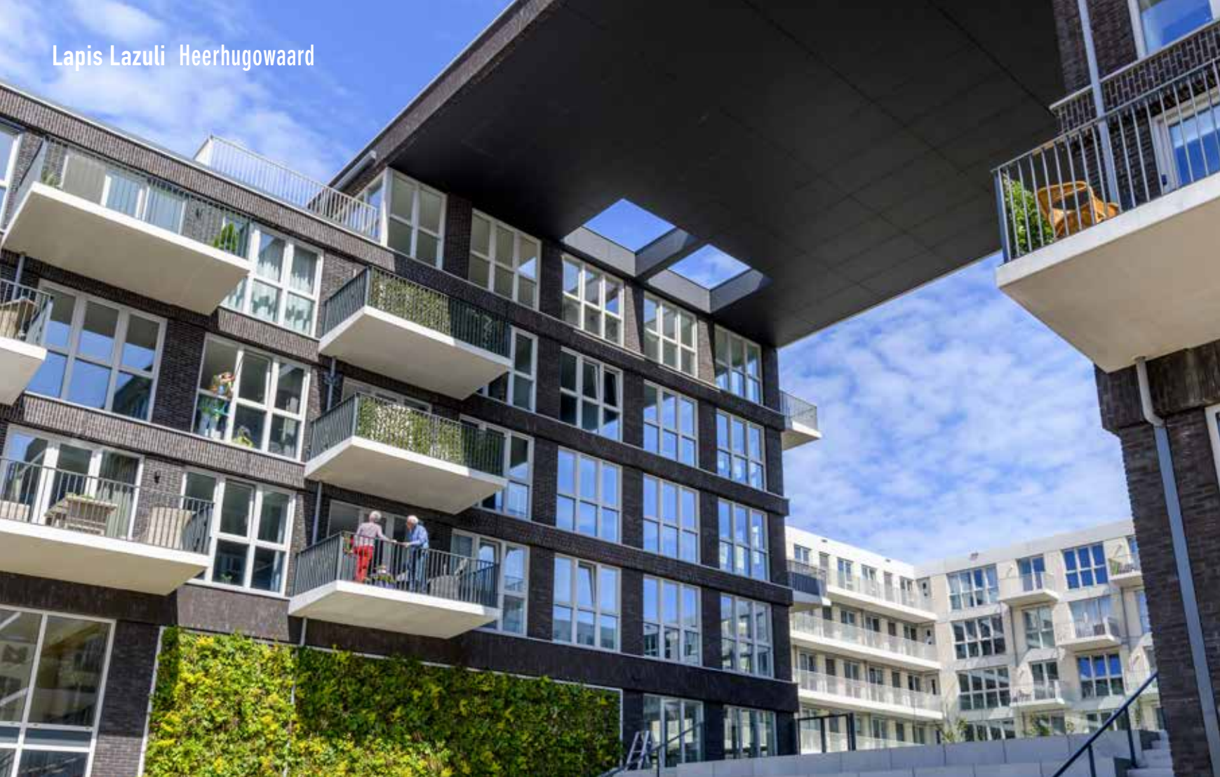
De woninggevels zijn afgewerkt met metselwerk in halfsteensverband en in een donkere tint. Voor de binnentuinzijde is gekozen voor een witte steen, waardoor een fijne lichte sfeer ontstaat.
