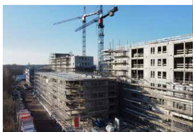
Zeer duurzaam is dat een bestaand en incurant gebouw met deze herbestemming een hoogwaardig tweede leven krijgt.
