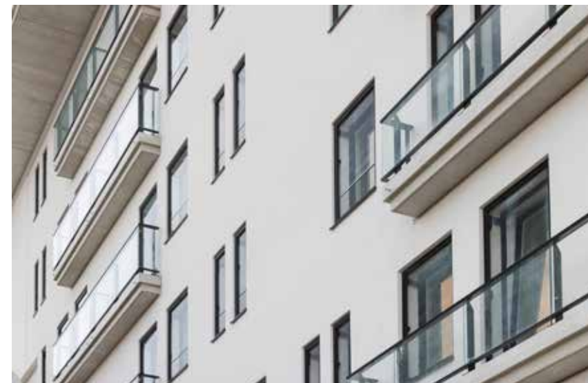
Met behulp van geluidsschermen bevestigd aan de kozijnen wordt de geluidsbelasting aan de snelwegzijde onder de grenswaarden van het Bouwbesluit gehouden.
