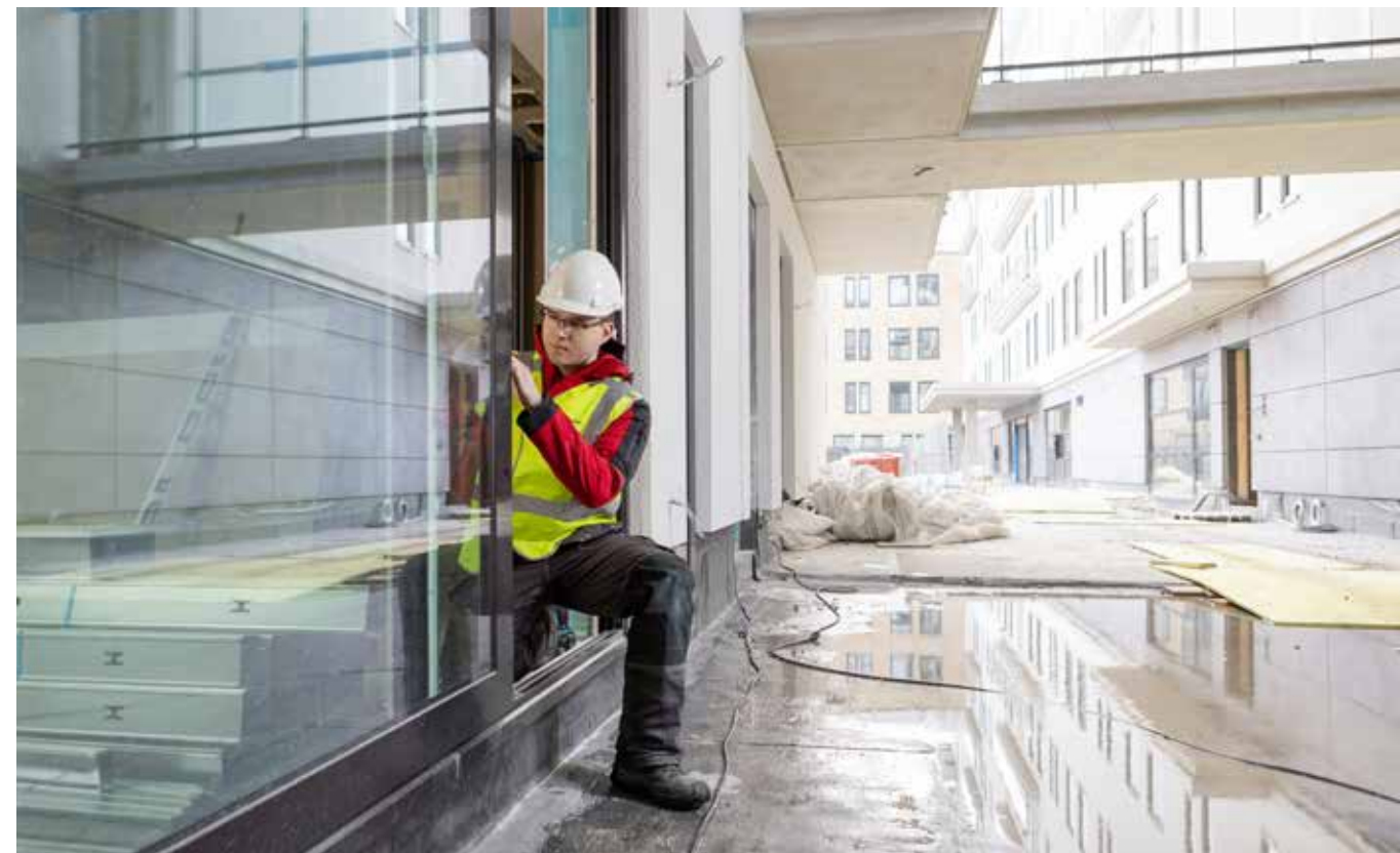
Alle kozijnelementen worden volledig beglaasd op het project aangeleverd, waardoor de doorloopsnelheid wordt verhoogd.
