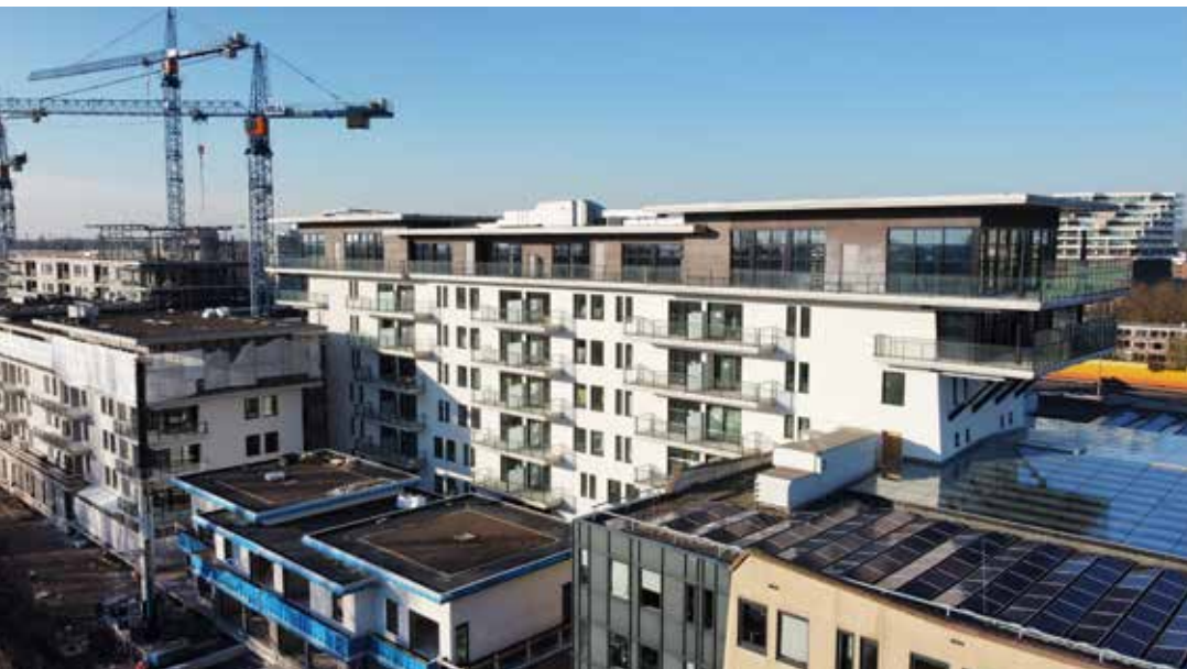
De penthouseconstructie wordt gerealiseerd op de dakvloer van het voormalige kantoorgebouw.
