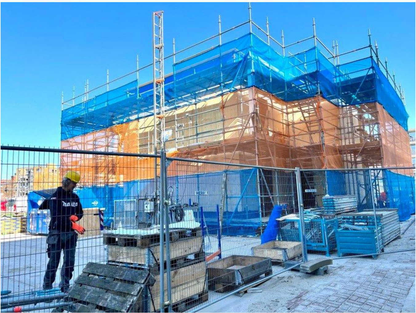
Op de Tangentlocatie wordt nu een proefopstelling gebouwd. © Foto Mediahuis/Roel van Leeuwen
