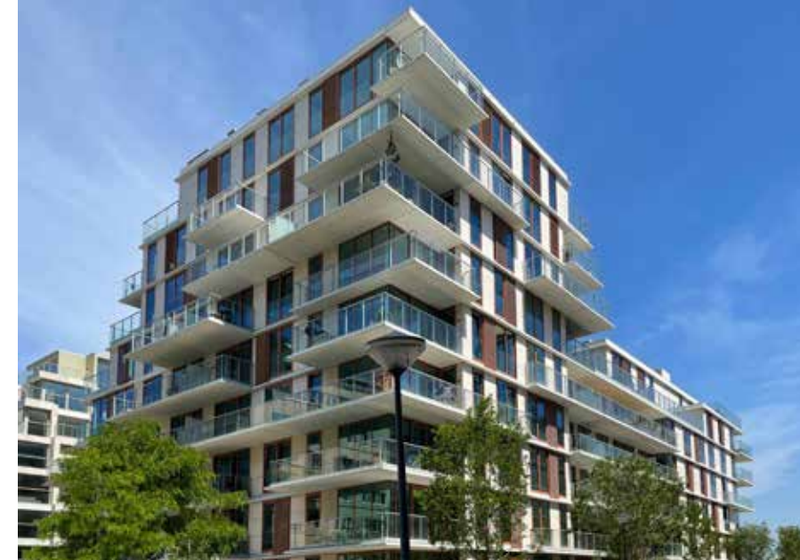
The Row is van de hand van DP6 architectuurstudio en omvat 92 huurappartementen.
