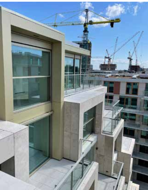
Het bouwkundig plan schreef voor dat de gevels van de gebouwen na vijf verdiepingen trapsgewijs terug moesten wijken. Bij The Grid gebeurt dit al vanaf de eerste verdieping.
