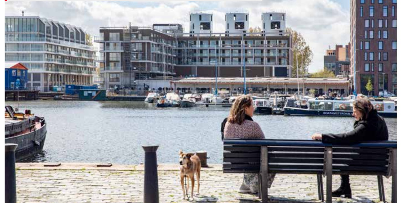
Met de silo's op het dak is het project een icoon voor het industriële verleden van het Cruquiseiland.
