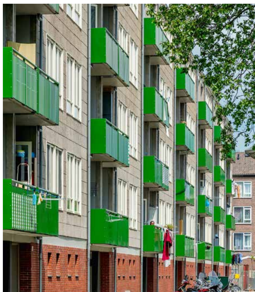
Alle woningen zijn tot op de constructie gestript en opnieuw afgebouwd.
