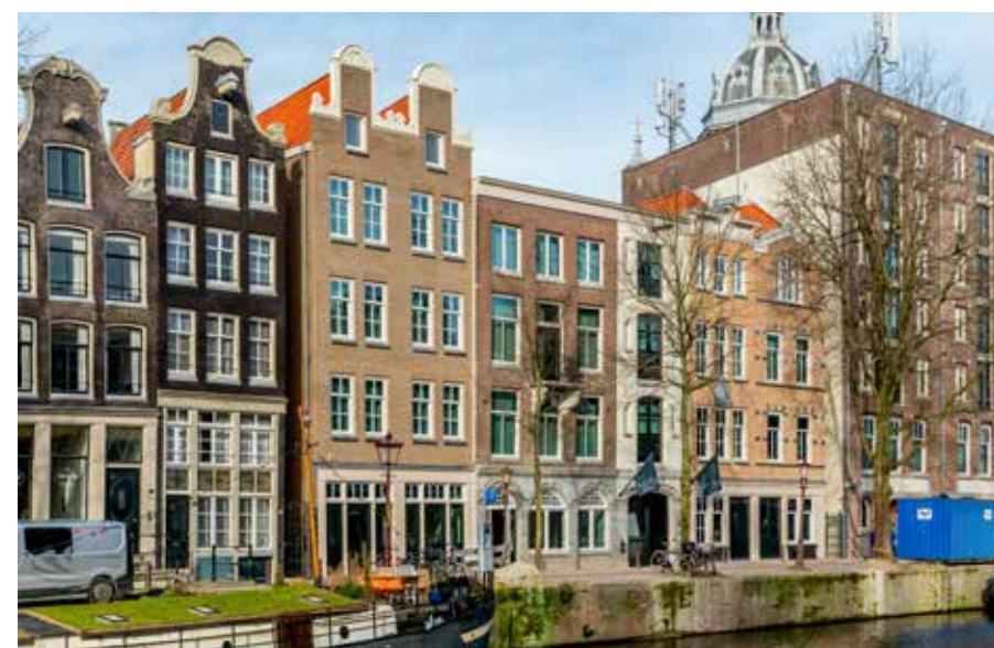
De nieuwste vestiging van Vondel Hotels is gerealiseerd in een zestal leegstaande, 17e en 18e eeuwse panden aan de Amsterdamse grachtengordel, die sinds enkele jaren op de Unesco Werelderfgoedlijst staan.
