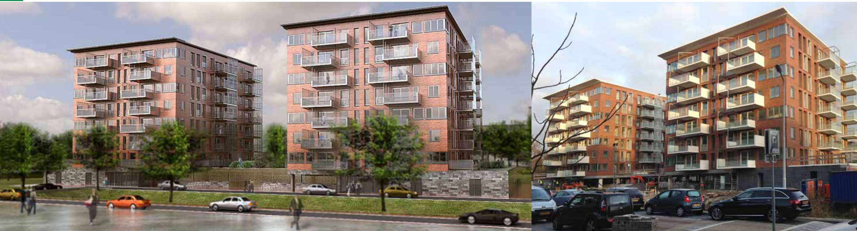
De gevel is afgewerkt met traditioneel metselwerk en geanodiseerde aluminium kozijnen.
